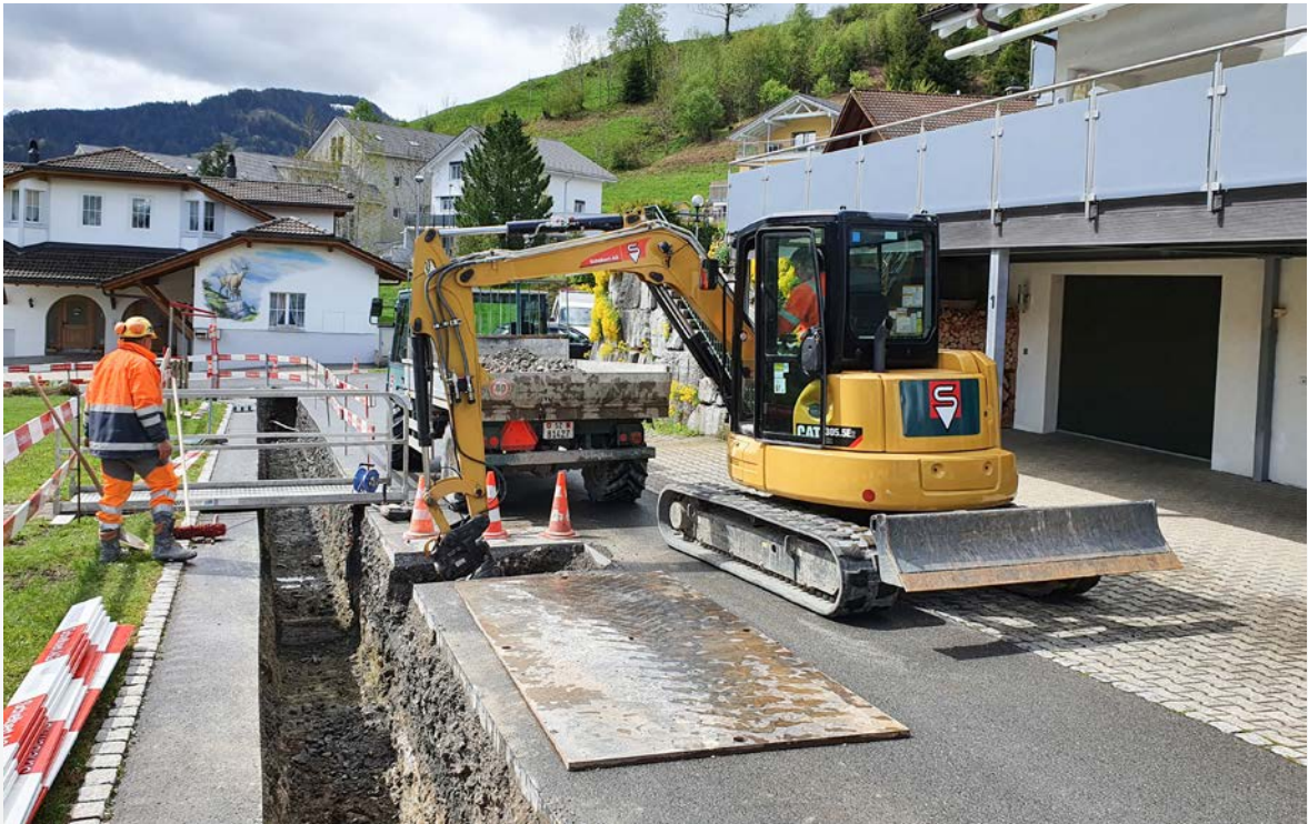
Der Graben ist vorbereitet für die Verlegung der Fernleitungen.
