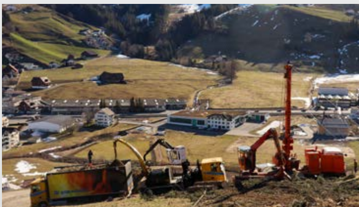
Holzernte mit eigenem Kombiseilgerät, Herstellung Hackschnitzel mit Partnerfirma und Wärmeerzeugung im eigenen Heizwerk, Rössliweid, Rothenthurm.
