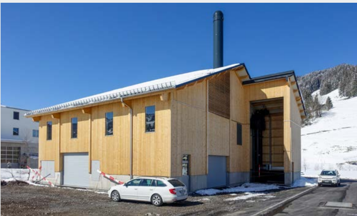
«Wärmeverbund Rothenthurm»: Das neue Heizwerk an der Landstrasse 5 in Rothenthurm
