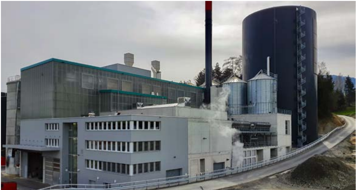
«Agro Energiezentrum Rigi AG»: Die Wärme-, Strom- und Pelletproduktion ist Ende September 2020 aufgenommen worden.
