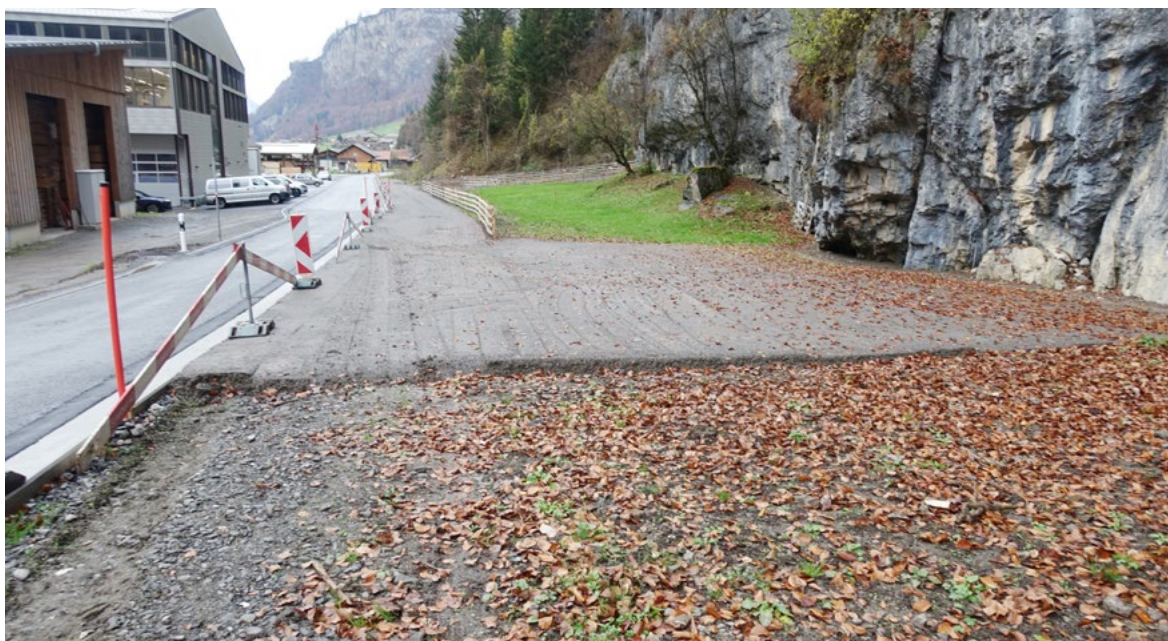
Erstellte Feinplanie auf dem Tierumschlagplatz.
