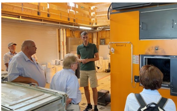
OAK-Mitarbeiter Gregor Lutz erklärt in der Heizzentrale den Wärmeverbund Rothenthurm.
