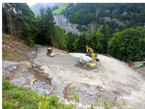
Strassenumlegung bei der Wendekurve in Arbeit
