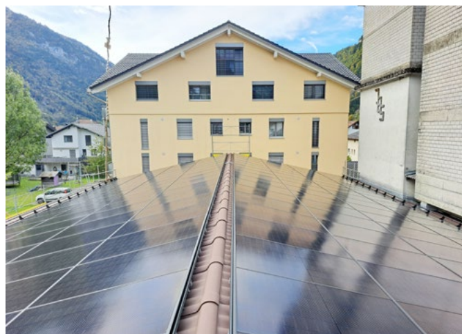
Die neue PV-Anlage auf dem Dach der alten Schreinerei an der Hauptstrasse 63a, Muotathal
