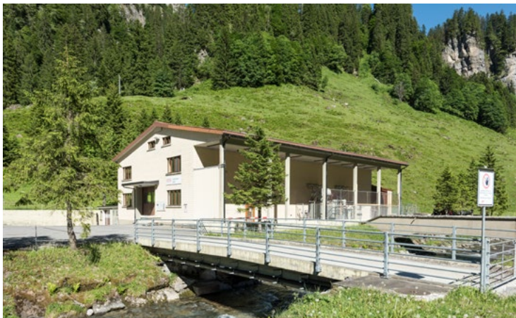
ebs-Kraftwerk Sahli, Muotathal
