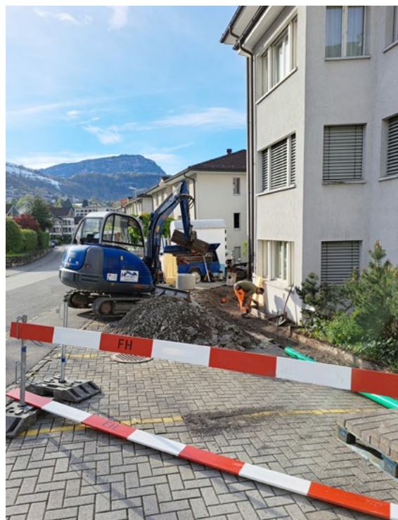
Erstellung Aufprallschutz bei den Besucherparkplätzen
