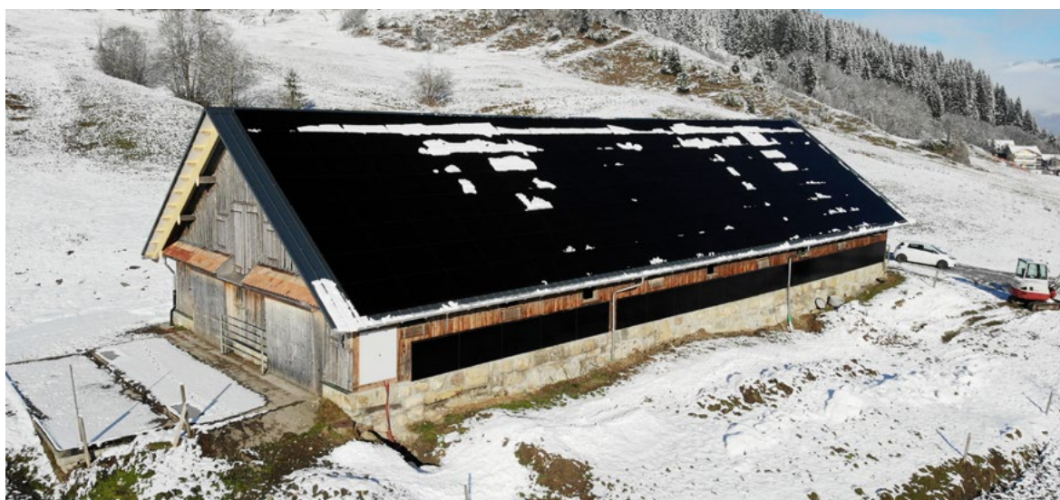
Neu installierte PV-Anlage
