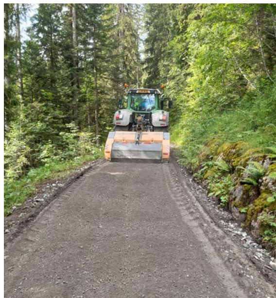
Unternehmung bei der Erneuerung der Verschleisssschicht an der Spilmettlenstrasse
