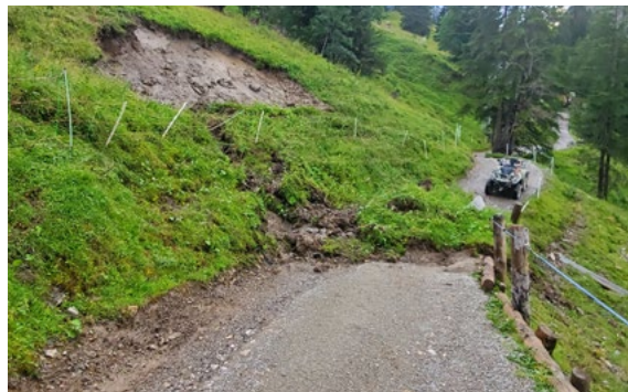
Hangrutsch an der Strasse Zwäcken-Hertenboden
