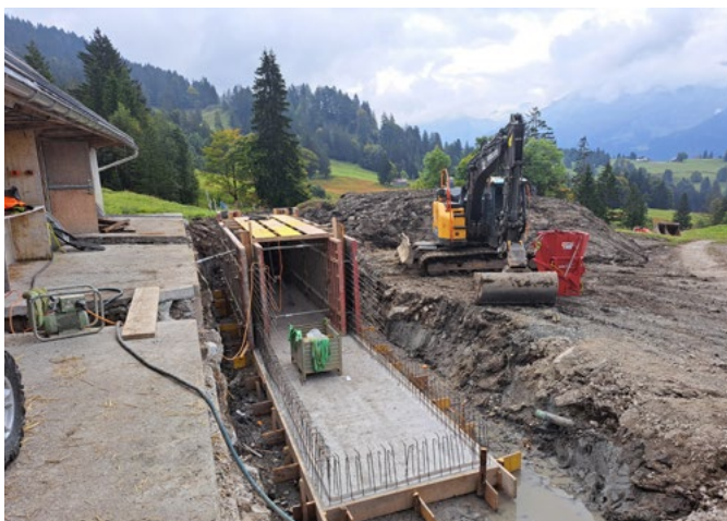
Auf der Alp Grossenboden, Schwyz, musste die Jauchegrube neu gebaut werden.
