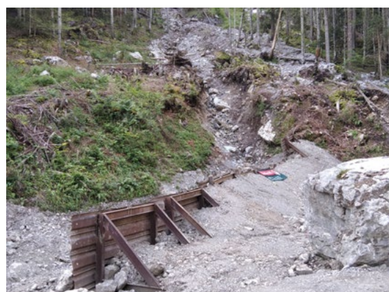
Provisorischer Ablenkdamm bei der Wendekurve der Lipplisbüelstrasse, Muotathal
