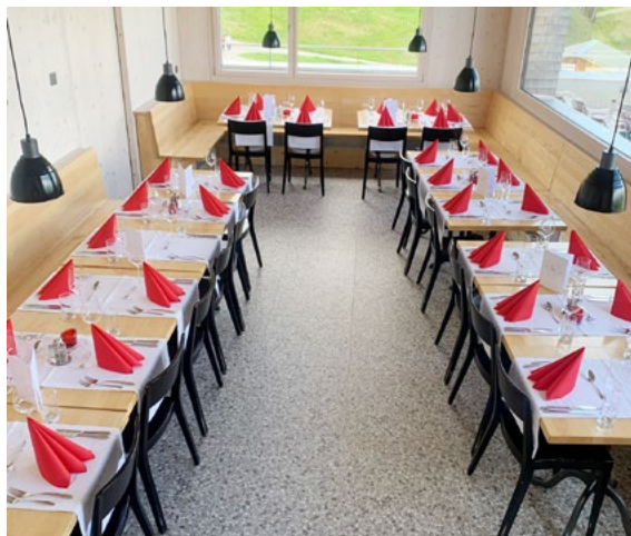
Der neu verlegte Plattenboden in der Stoos Hüttä hat sich bewährt.
