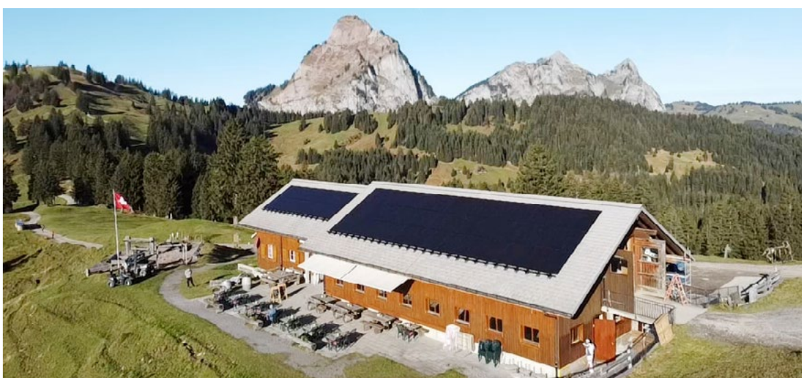
Das Alpgebäude Zwäcken mit frisch gestrichener Fassade und neuer PV-Anlage
