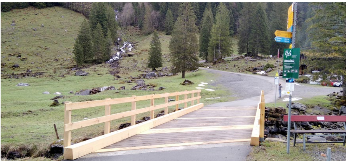
Die Brücke im Sahli hat ein neues Holzgeländer und Seitenschwellen erhalten.
