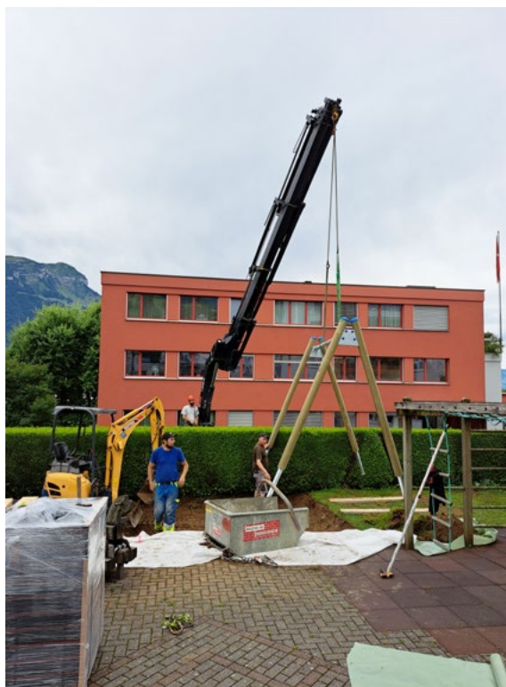
Montage der neuen Schaukel
