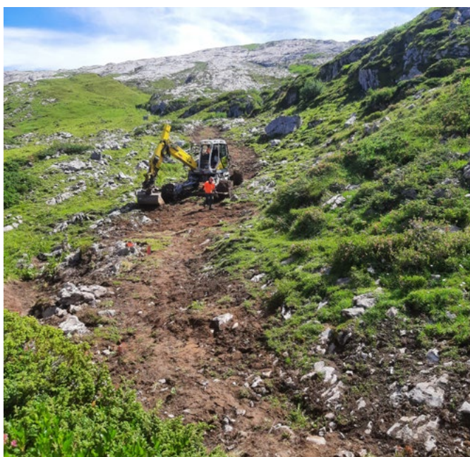
Auch im Jahr 2024 wurden etliche Meter Wasserleitungen im Boden vergraben – hier im Gebiet Bödmeren, Muotathal.
