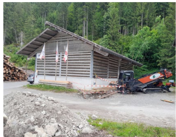
Für den Stromanschluss der Schnitzelhalle Eigen erfolgte eine Spülbohrung unter der Minster durch.
