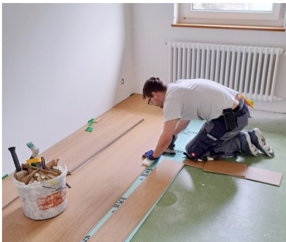
Der neue Boden in der Rösslimatt 1, Seewen, wird verlegt.
