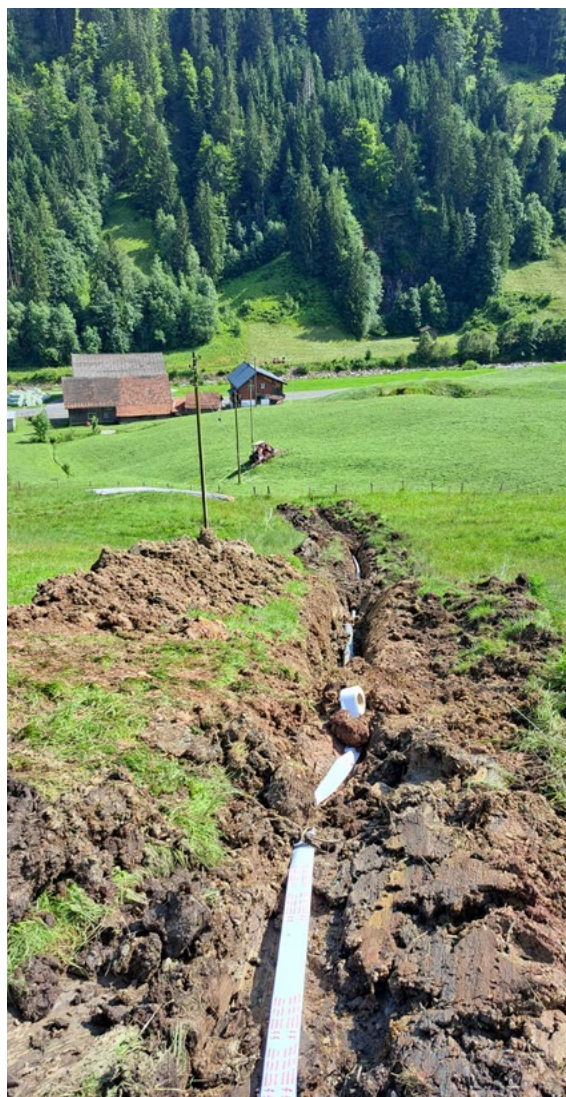
Neue Leitung für die Netzeinspeisung zur Usser Plangg
