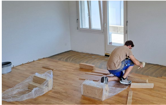
Einbau neues Parkett im Brühl 4 in Schwyz
