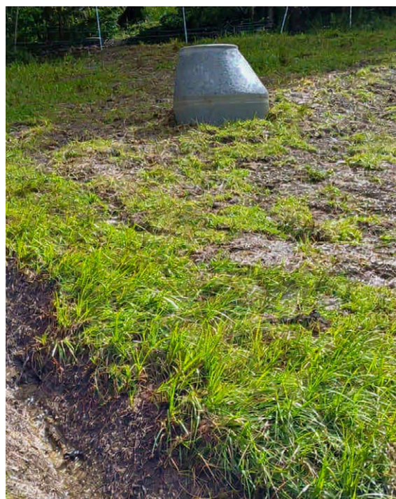
Neu gesetzter Sammelschacht auf dem Waffenplatz Altmatt, Rothenthurm
