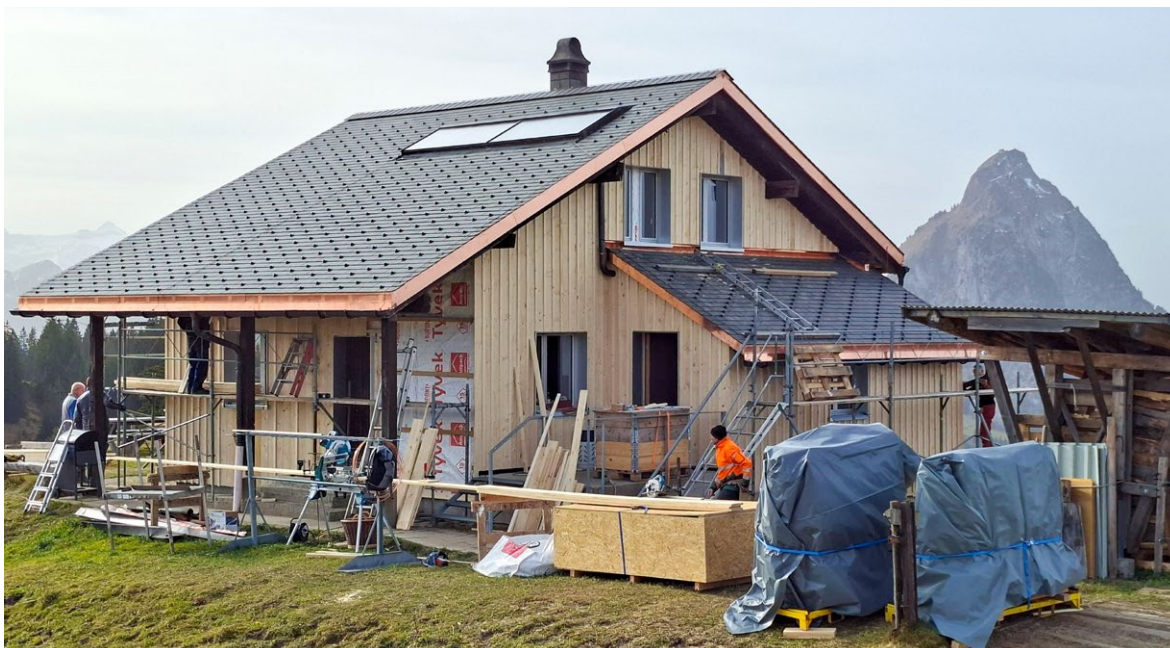
Alpgebäude Furgelen während der Sanierungsarbeiten
