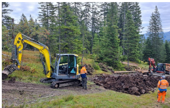
Arbeiten am Erschliessungsweg Furggelen
