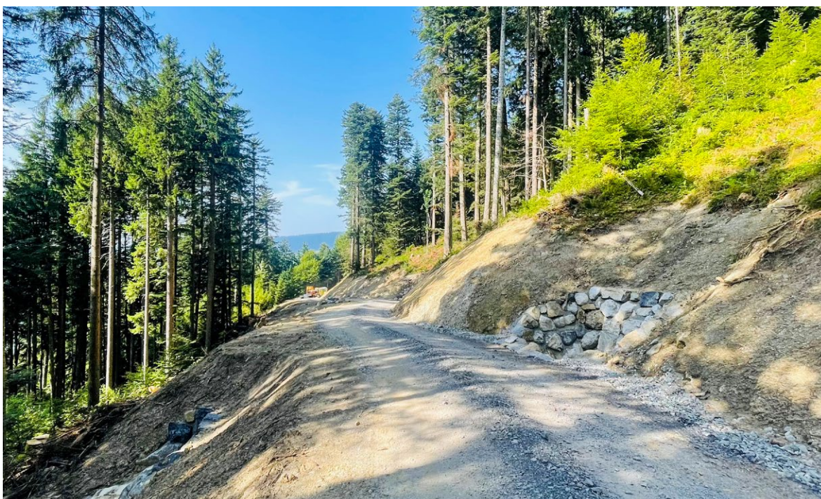
Neubau lastwagenbefahrbarer Maschinenweg, Chli Morgarten, Rothenthurm
