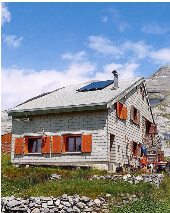
Das Alpgebäude Erigsmatt mit der neuen PV-Anlage ...
