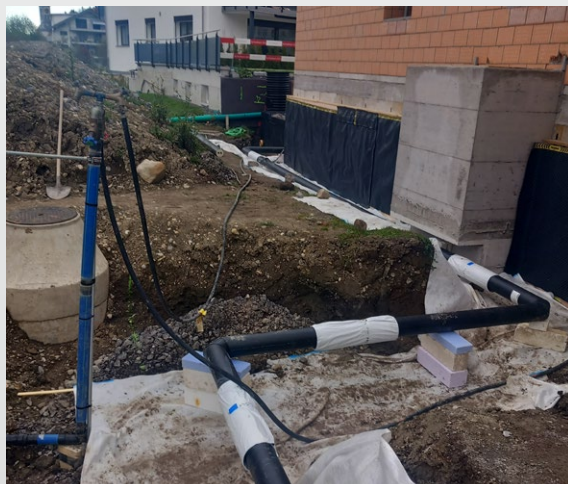
Fernwärmenetzbau in der Landstrasse (Rittlisgatter) in Rothenthurm
