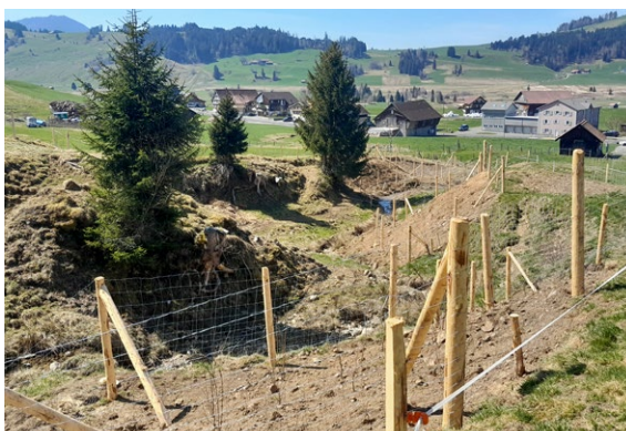
Arbeiten für Dritte: Ersatzmassnahmen Kantonsstrasse H8 in Rothenthurm – Pflanzung Sträucher
