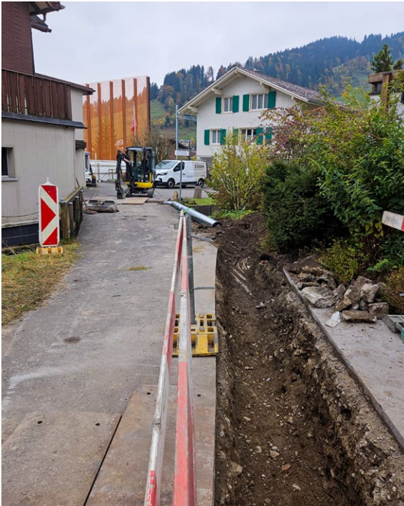
Fernwärmenetzbau in der Unterdorfstrasse in Rothenthurm
