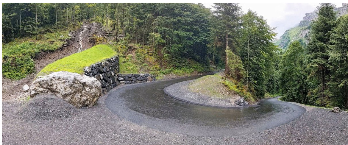
Fertiggestellter Schutzdamm mit Wendekurve Lipplisbuelstrasse, Muotathal
