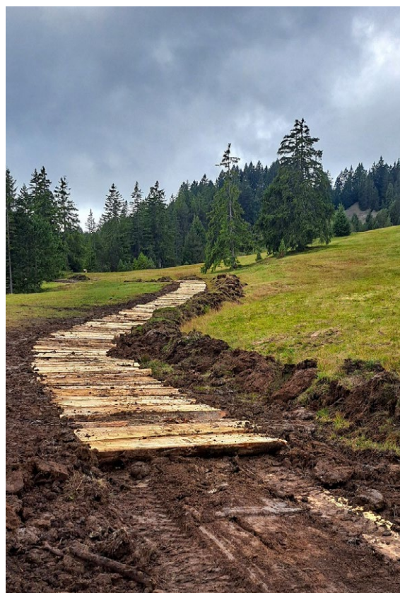
Einbau der Prügelkonstruktion im Gebiet Hobacher
