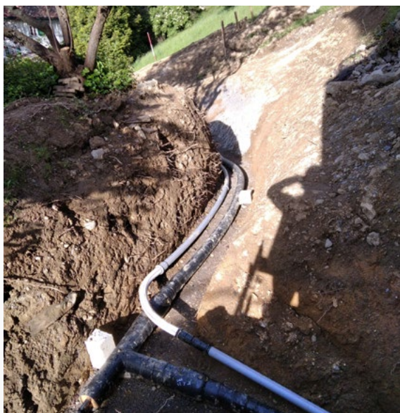
Fernwärmenetzbau in der Turmmatt in Rothenthurm
