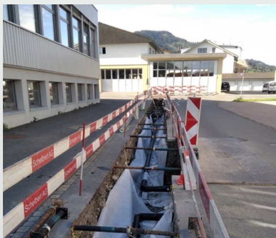
Fernwärmenetzbau in der Biberstrasse in Rothenthurm
